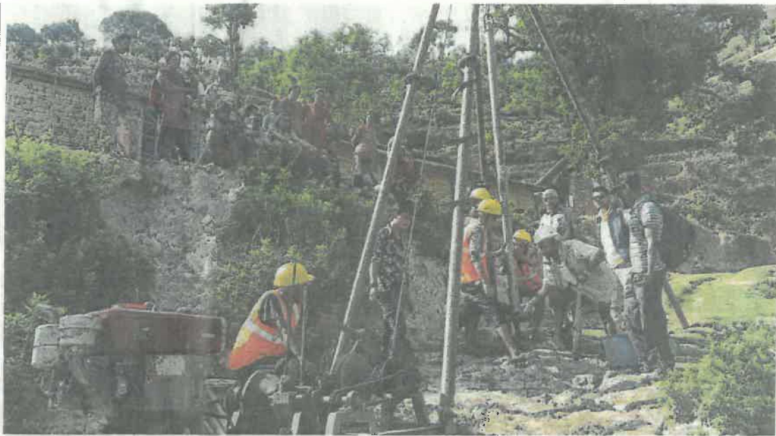
Auf Initiative des Vereins „Zukunft für Nepal Ostwürttemberg“ entsteht in Jeevanpur in Nepal ein Berufsbildungszentrum. Um erdbebensicher bauen zu können, wurde die Geologie des Untergrunds erkundet. FOTO: PRIVAT
